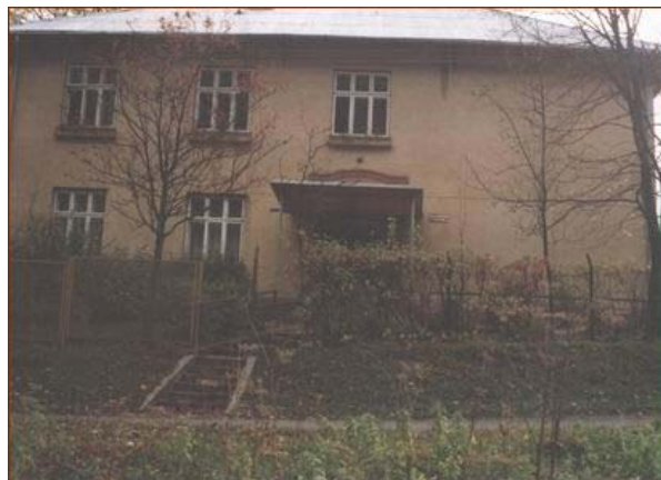
Fot. 2. Budynek szkolny w Czaczowie z roku 1911 po nadbudowie
